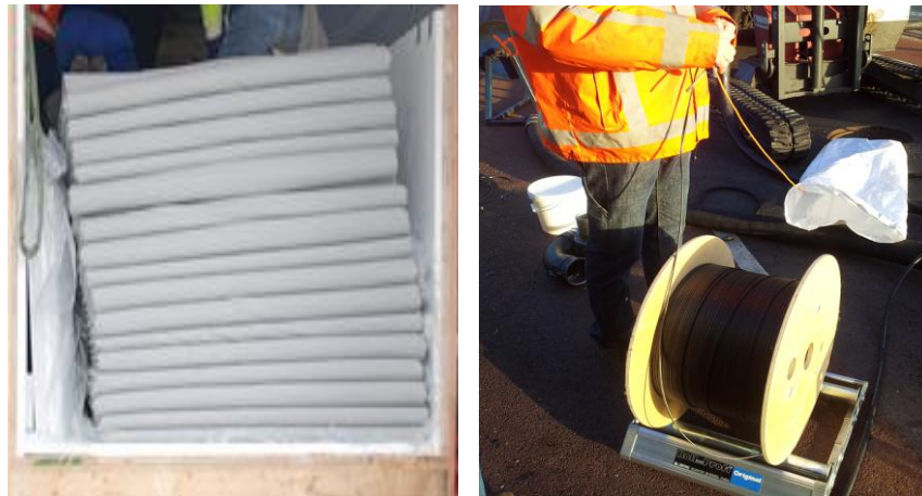
Bild 2.2: Temperaturmesskabel für die werkseitige Linerintegration (rechts) und für den Einzug in den Abwasserkanal (links)
